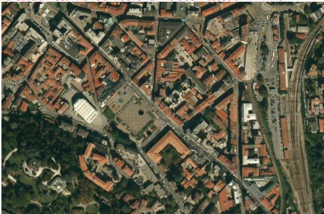
Foto 1 – Vista aerea dell'area oggetto d'intervento
